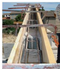
Mise en place d'un chaînage au niveau du rampant d'un bâtiment
