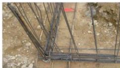
Noeud de chaînage - Continuité mécanique
