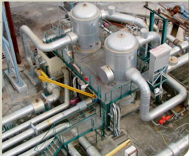
Centrale géothermique de Bouillante, à Bouillante, en Guadeloupe.
