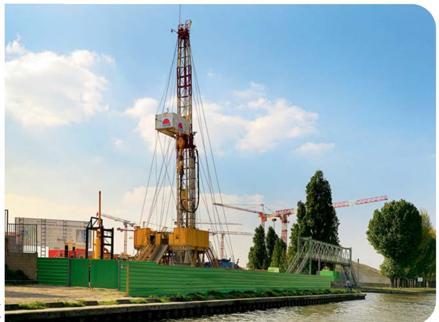
Forage de géothermie profonde à Paris – CPCU.
