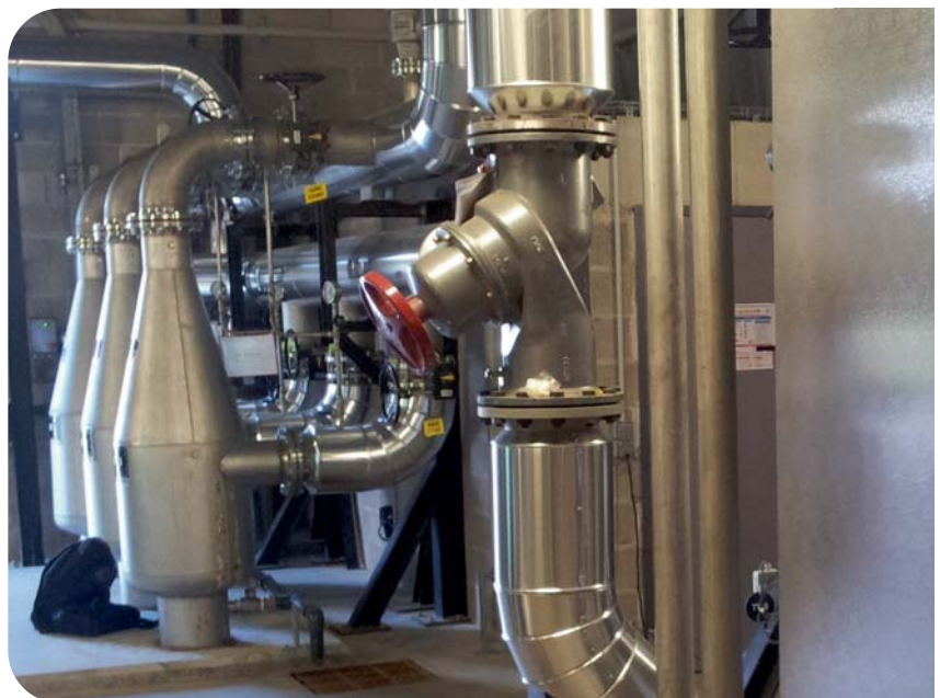
Filtere de la centrale géothermique de Lognes (DALKIA).
