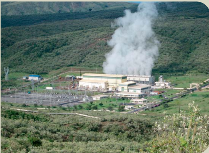
Centrale géothermique d'Olkaria 2 (Kenya).
