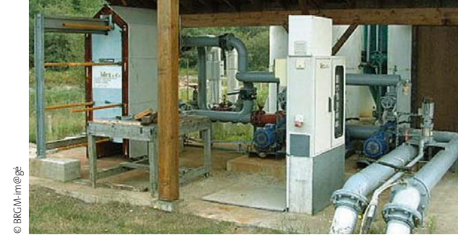
Installation géothermique pour le chauffage de la pisciculture de Mios le Teich (Gironde) à partir d'anciens forages pétroliers.
