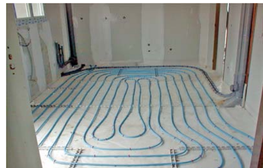
◀ Plancher chauffant constitué d'un réseau de tubes en polyéthylène noyé dans une chape en béton.
