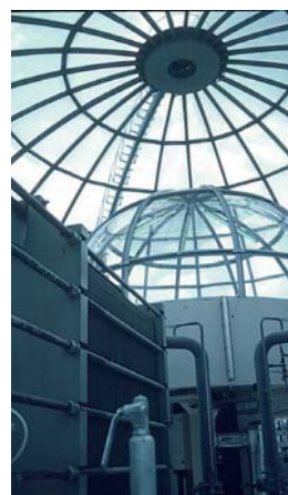
▶ Les deux demi-sphères translucides abritent les installations de chauffage géothermique. Cet ensemble alimente en eau chaude le réseau de chauffage urbain d'une partie des immeubles de la banlieue de Meaux.
