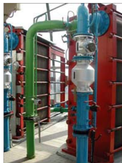
▼ Echangeur à plaques de titane qui permet de transférer les calories de la boucle géothermale au circuit de distribution de chaleur.
