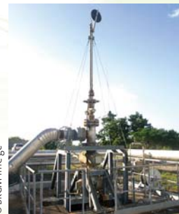
▲ Tête de puits à Bouillante.
