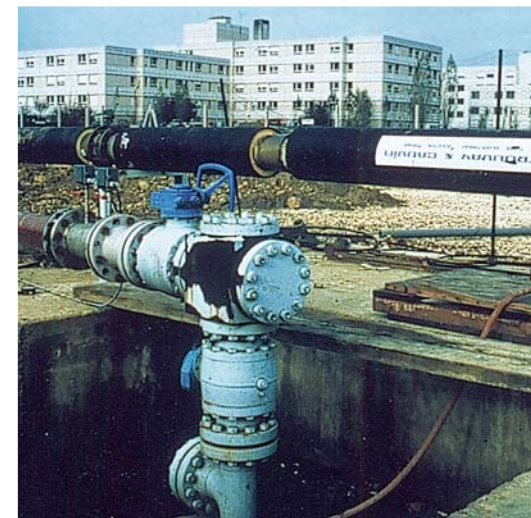
◀ Tête de puits d'un forage géothermique dans le Dogger, l'aquifère qui offre aujourd'hui la plus grande densité au monde d'opérations de géothermie en fonctionnement.
