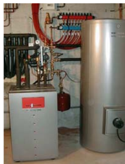
▼ Pompe à chaleur géothermique.
