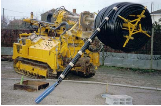
◀ Sonde géothermique prête à être installée dans le forage vertical.
