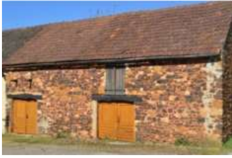
Fig. 2-12. - (a) Cabane construite « à pierres sèches » dans les anciennes vignes à partir de matériaux jurassiques, (b) mur et porte édifiés avec des blocs de calcarénite du Crétacé vulnérables aux agressions des intempéries, (c) façade de grange dans un hameau localisé sur les altérites tertiaires. © J.-J. Jarrige
